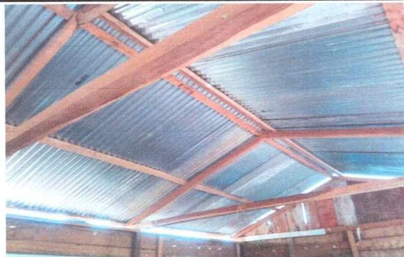
FOTO 3 SE OBSERVA EL TECHO DEL ESTABLECIMIENTO EN MAL ESTADO
